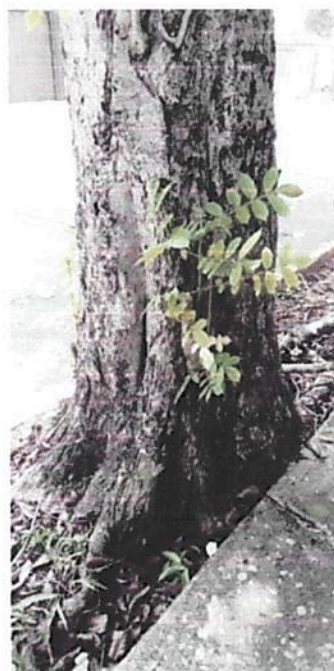
Figura 4. Raíces del árbol afectando la banqueta.
